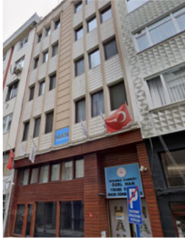
• Şahin Apartmanı Kadıköy / İSTANBUL
