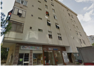
• Park Apartmanı / Özgürlük Parkı Kadıköy / İSTANBUL
