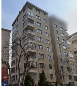
• Hamdibey Apartmanı Kadıköy / İSTANBUL
